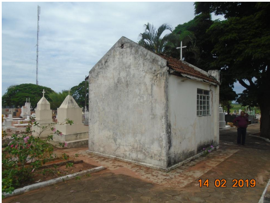
TELHADO CERÂMICO SERÁ SUBSTITUÍDO
