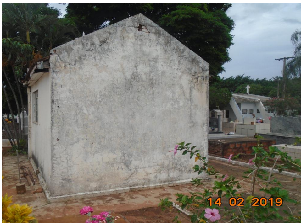
REBOCO DAS PAREDES DANIFICADOS A SEREM REFEITOS
