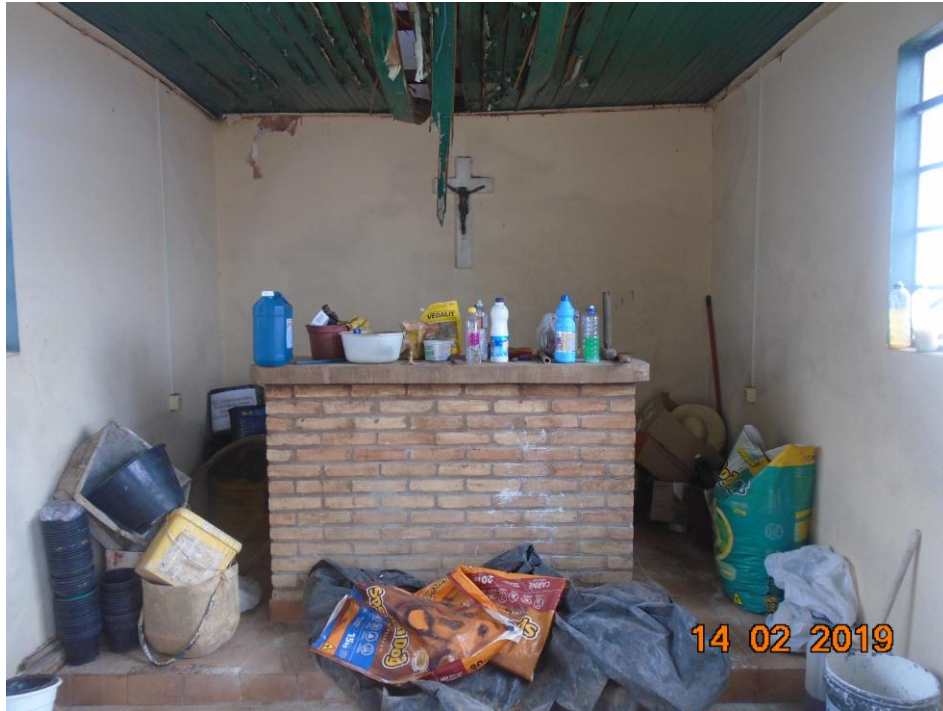
ALTAR COM PLACA DE CONCRETO SERÁ SUBSTITUÍDO POR TAMPO DE GRANITO
